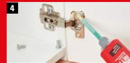
Gegebenenfalls durch das Schraubenloch des Scharniers noch mal nachfüllen.
