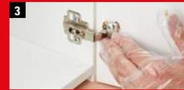
Scharnier innerhalb von 30 Sekunden in die ausgebrochene und bereits aufgefüllte Stelle eindrücken.
