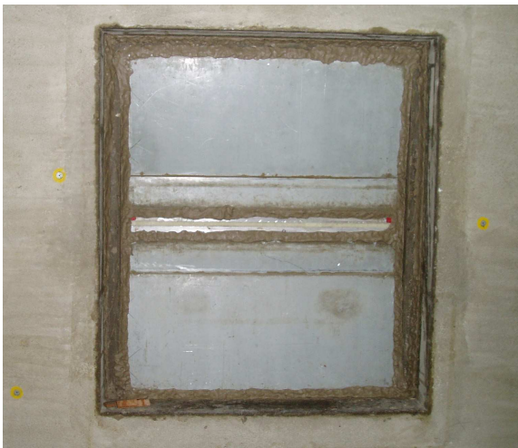
Bild 3 Foto des eingebauten Elementes (erstellt vom ift Schallschutzzentrum)
