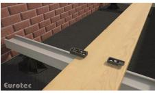
2) Fixieren Sie das Bauteil 2 des StarterClips auf der Oberseite der Terrassenunterkonstruktion.
