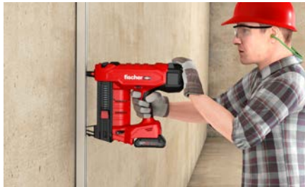
Für die schnelle und zuverlässige Befestigung von Trockenbau-Schienen
