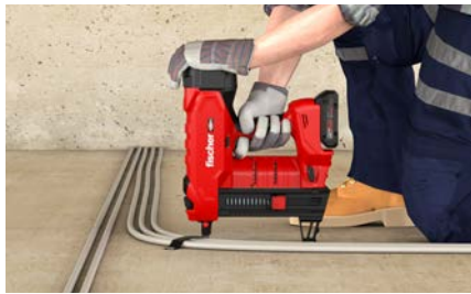
Das schnelle Befestigen ermöglicht es, die Arbeit in kurzer Zeit zu erledigen
