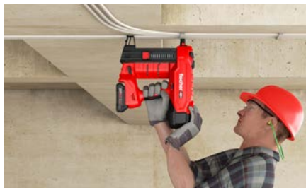
Das FXC 85 & FGC 100 eignet sich aufgrund seiner optimalen Balance perfekt für Befestigungen an Decken
