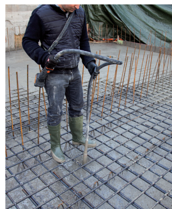
Leicht und effektiv Beton verdichten
